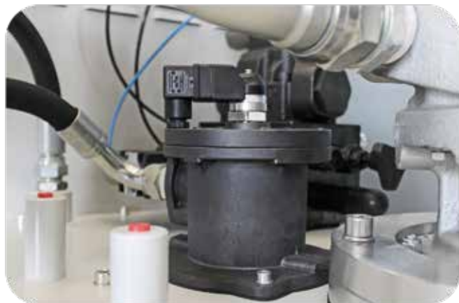
Filtro olio idraulico con indicatore meccanico per l'avviso di sostituzione del filtro dell'olio idraulico.
